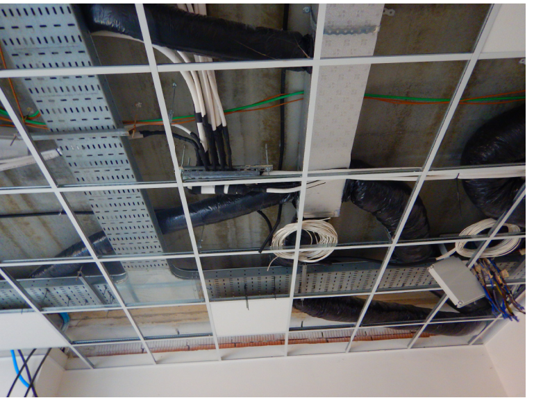
foto 3 - rifare giunti impianto climatizzazione
